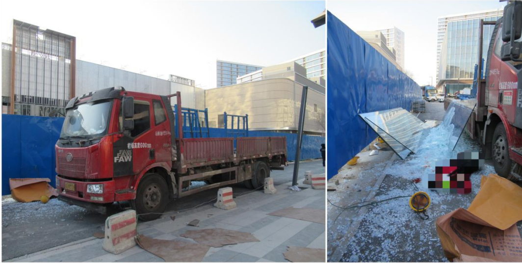
事故现场照片
